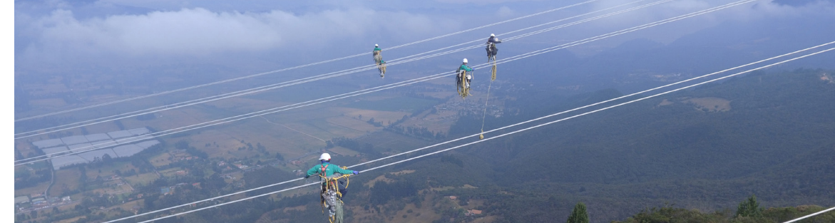
Mantenimiento de líneas de transmisión en Guavio-Circo
