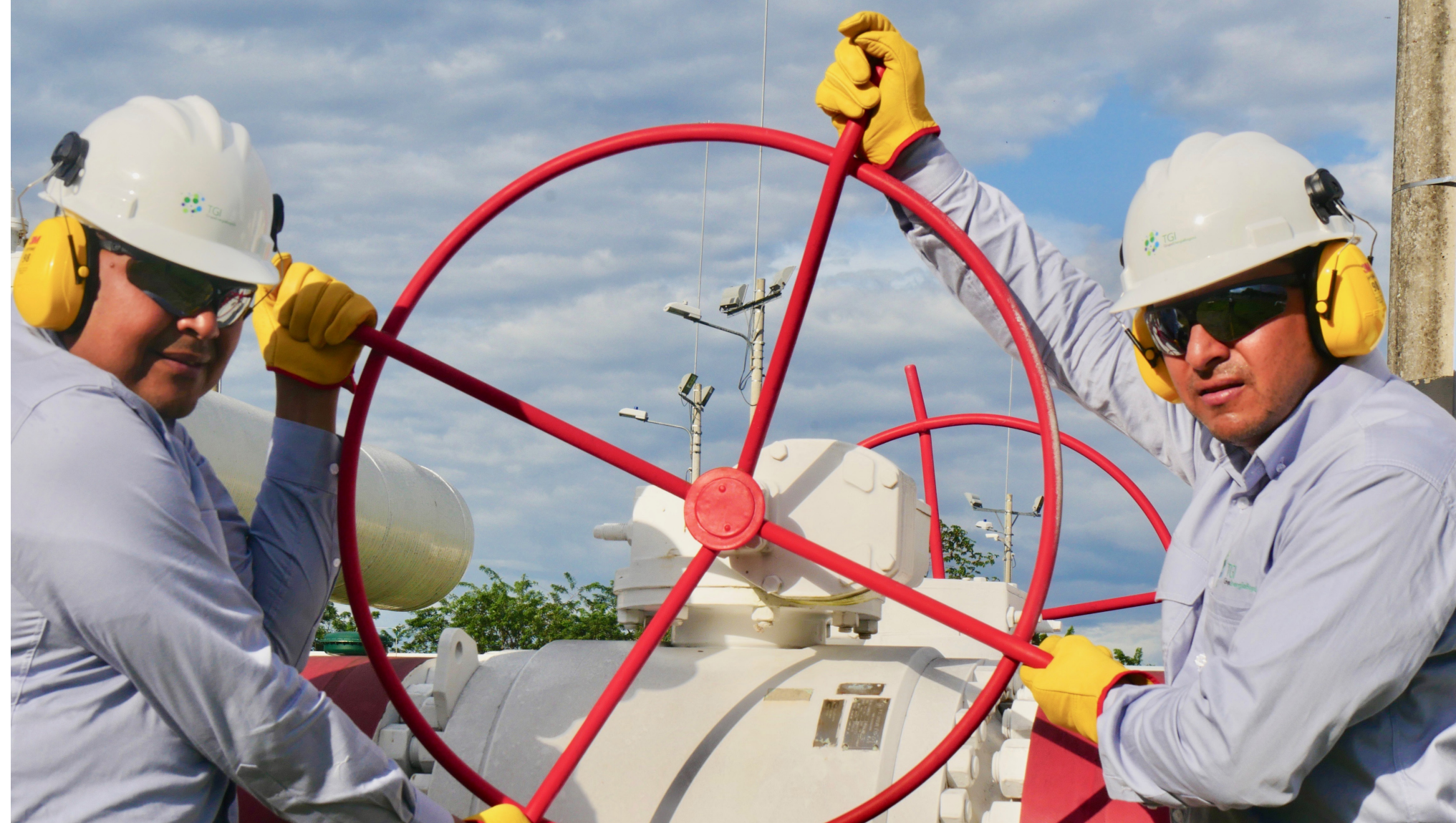
Colaboradores de TGI en la estación de compresión de Mariquita (Tolima)
