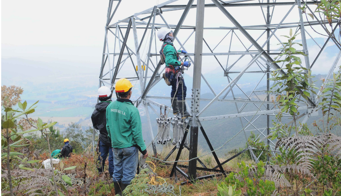
Levantamiento de torre de transmisión del proyecto 309 en Pradera (Valle), proyecto Tesalia- Alférez
